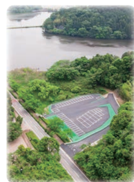
完成した平の沢中池駐車場
